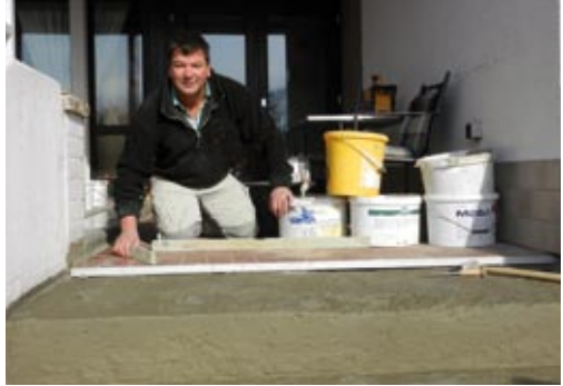
Mitarbeiter der Fa. Volmer bei der Erneuerung der Außentreppe
